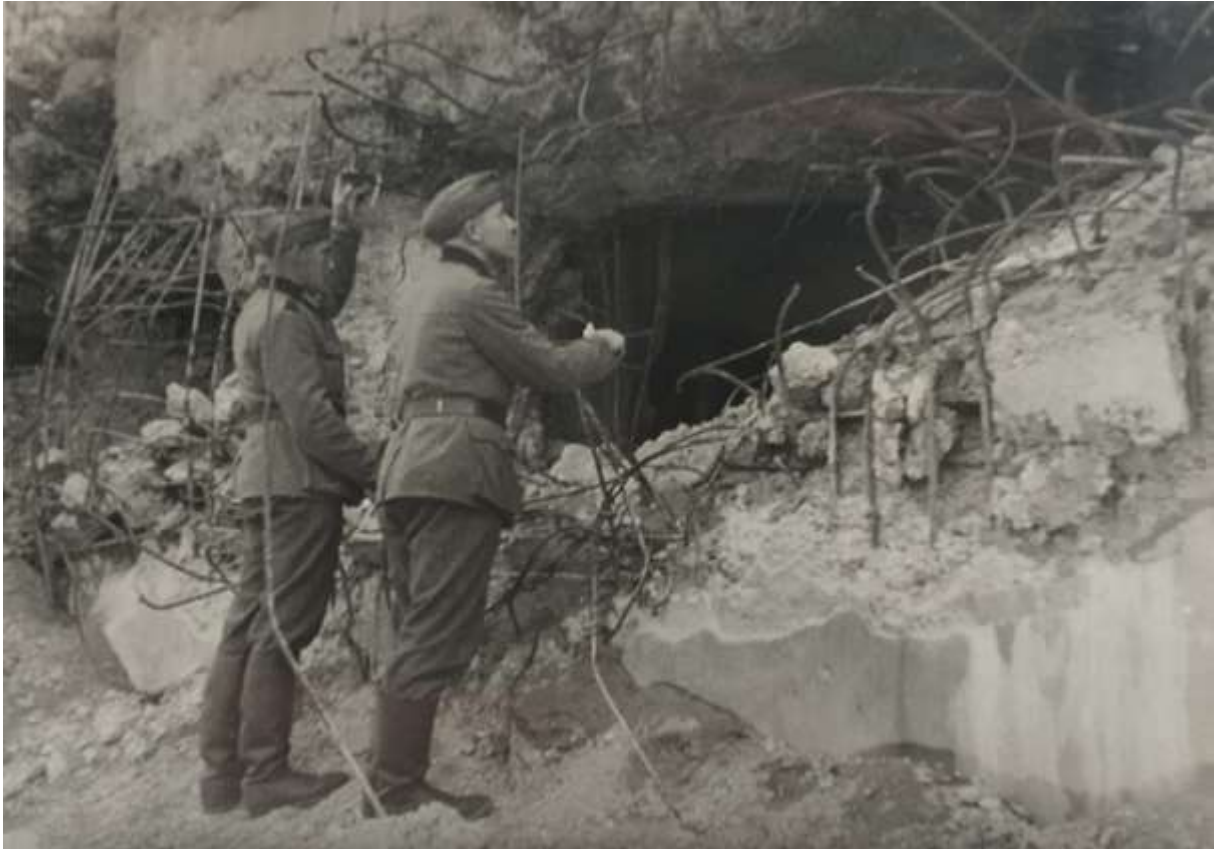
Auf der Rückseite: Zerschossener Bunker am Rhein im Elsass
