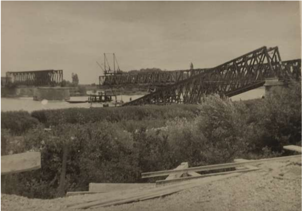
Auf der Rückseite: Rheinbrücke bei Breisach, von Franzosen gesprengt
