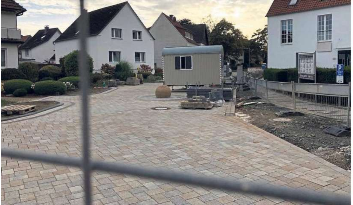
Letzte Pflasterarbeiten und der Feinschliff an der Kurpromenade stehen noch an. Dann ist sie fertig - deutlich früher als ursprünglich geplant.
