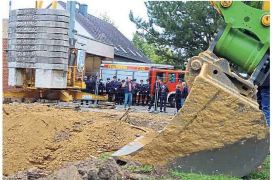
Der Bagger ist am Feuerwehrgerätehaus bereits voll im Einsatz.
