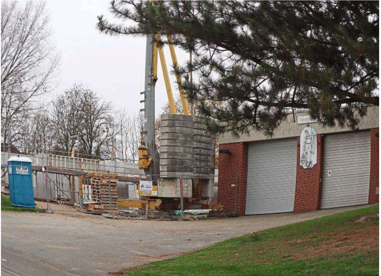
Vom neuen Feuerwehrhaus in Bad Westernkotten steht bereits das Erdgeschoss. Foto: Dietz
