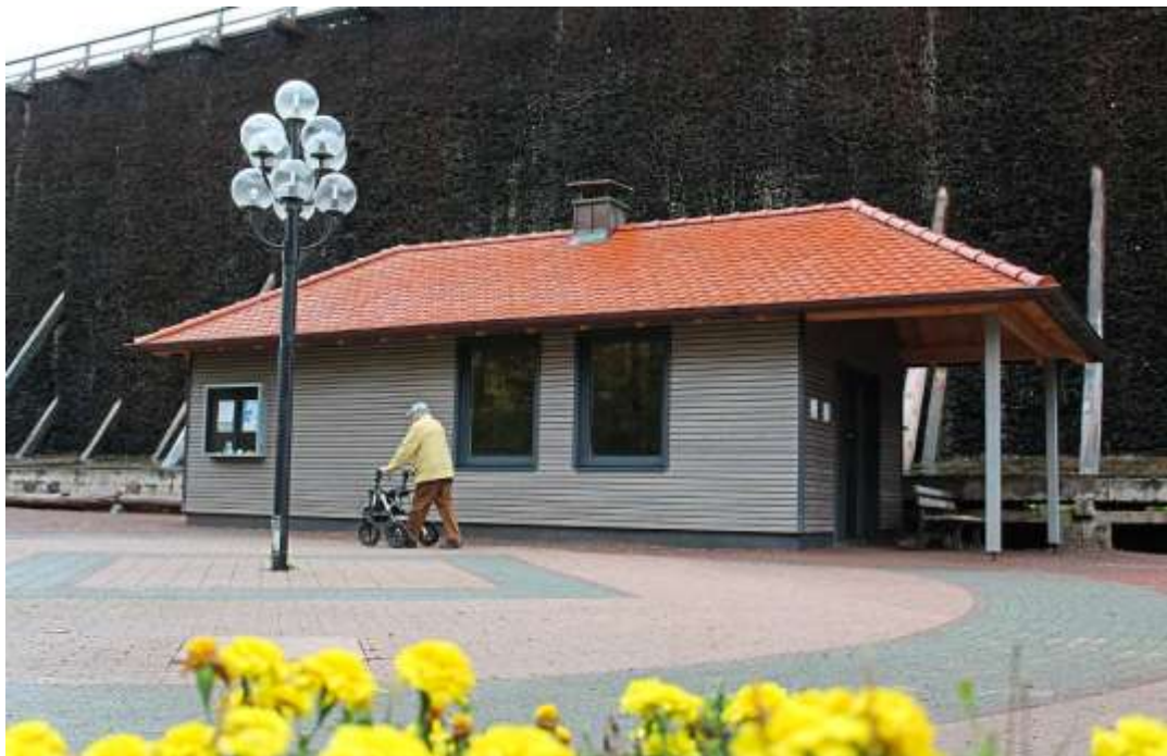
Mithilfe der Leader-Projektförderung wurde das alte Pumpenhaus im Kurpark durch ein neues Siedehaus ersetzt. Foto: Mintert
