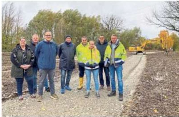
Kanal und Rückhaltebecken: Die Arbeiten an der Wormei in Schmerlecke sind jetzt gestartet.
