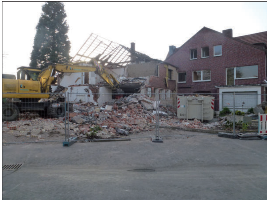
Bei Köneke an der Wolfsangel befand sich während des 2. Weltkrieges ein Gefangenenlager. Hier eine Aufnahme vom Abriss des Gebäudebestandes am 22.4.2015.
