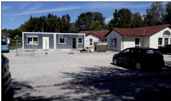
Während der Bauphase: Aufnahme vom 03.07.2018...
