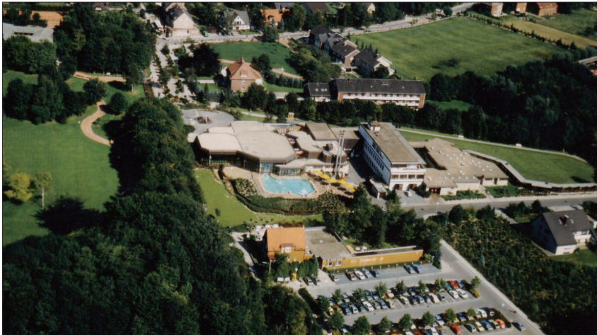
Luftaufnahme des Kurmittelzentrums aus dem Jahre 1988. Vorn der Großraumparkplatz mit dem Gasthof "Treffpunkt" (heute Hotel zur Therapie), den Hellweg-Sole-Thermen (1981), dem Kurmittelhaus (1973) und dem Erweiterungsbau nach Süden (später Orthopädisches Zentrum).
