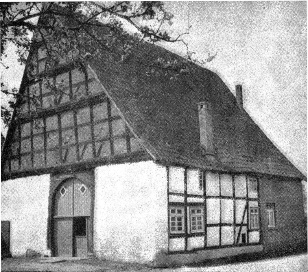
Haus Willi Kemper, 1955 abgebrochen. Den Giebel hat der Landschaftsverband erworben, er ist in Warstein untergebracht. Der Landschaftsverband beabsichtigt, ein Museumsdorf zu bauen, in dem auch der alte Giebel Verwendung finden soll
