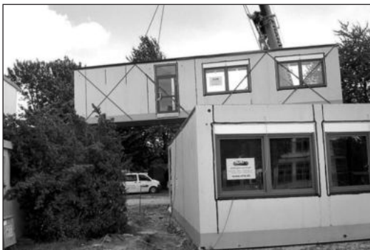
2007: Die Bauteile der IOGS "schweben" ein.
