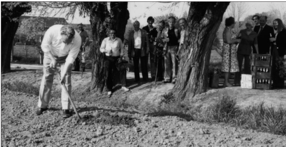
1. Spatenstich für das "Sanatorium Wiesengrund" am Mühlenweg am 15.5.1979 durch den Hauptkommanditisten Josef Lüning.
