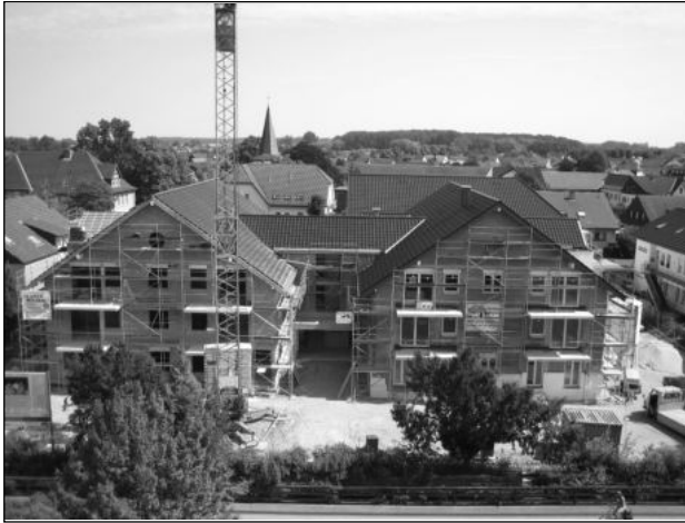
Service-Wohnanlage "Am Osterbach", Aspenstraße 5. Aufnahme vom 4.8.2007, während der Bauphase.
