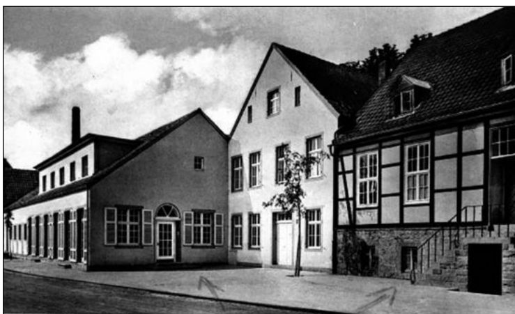
Rechts das Mütterkurheim, noch mit Freitreppe.
