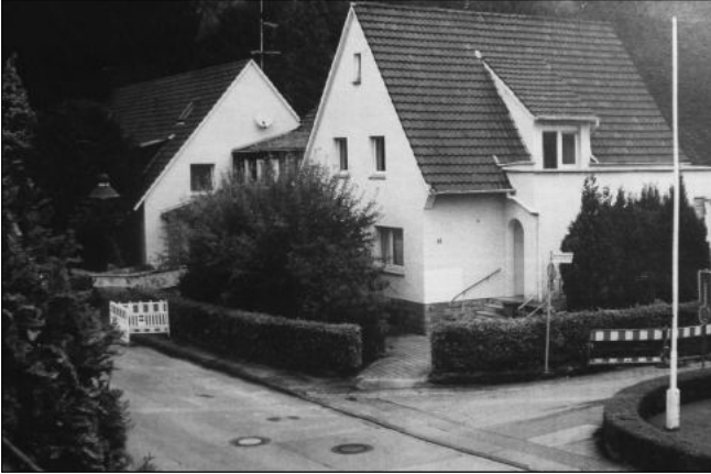
Das ehemalige Seniorenpflegeheim Haus Tanneck kurz vor dem Abriss 2010.
