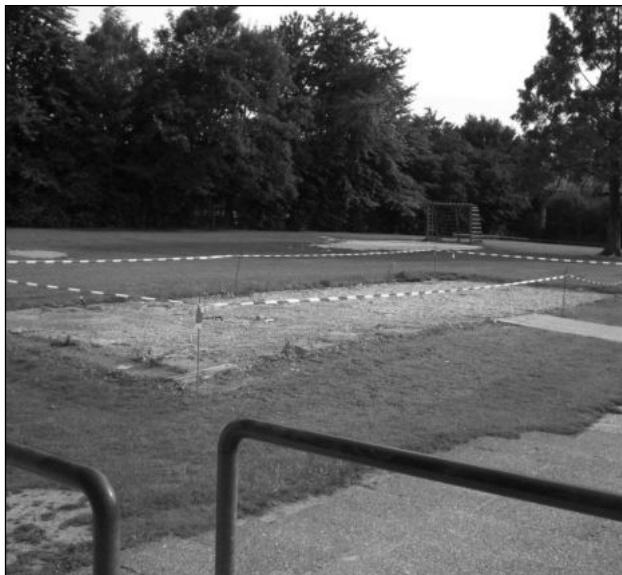
2007 wurde auch die IOGS (Integrierte offene Ganztagschule) eröffnet. Das Foto vom 7.6.2007 zeigt die Fertigstellung der Fundamente.
