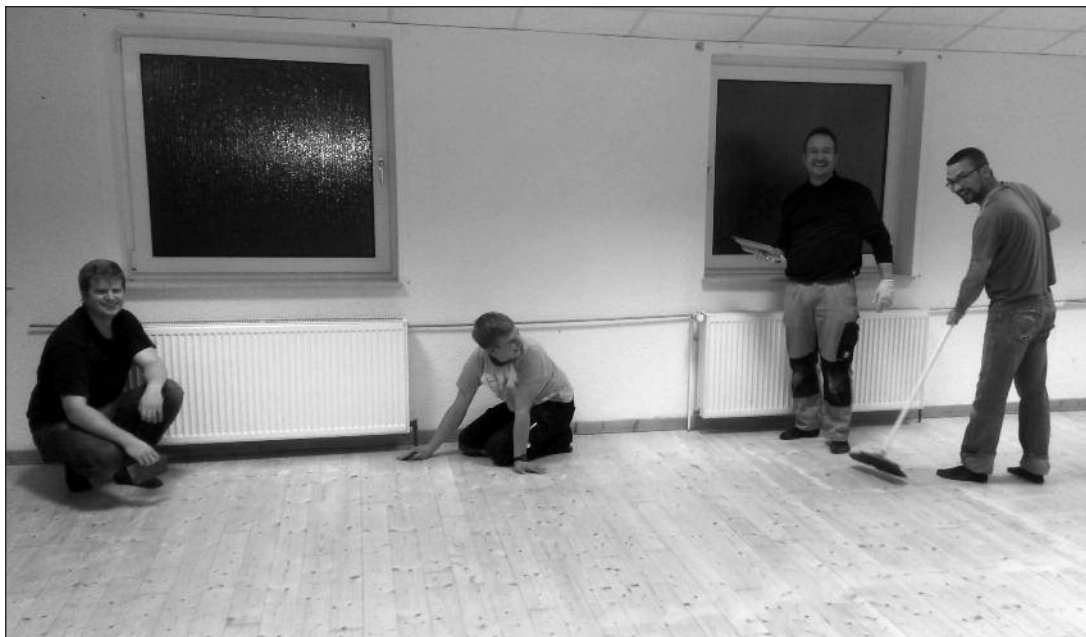
Beim Abschleifen des Holzfußbodens.
