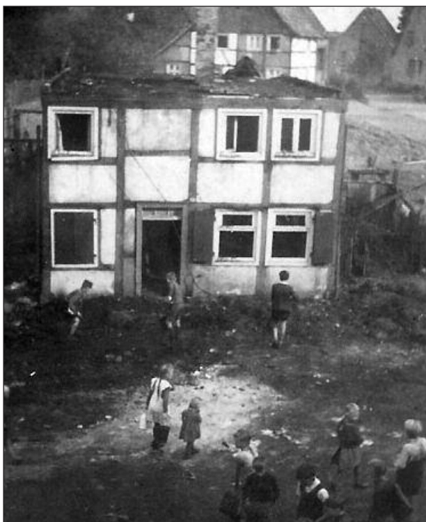
Der Dachstuhl des ehemaligen Wohnhauses Köneke, früher Alter Markt, wurde völlig zerstört. Blick nach Norden.
