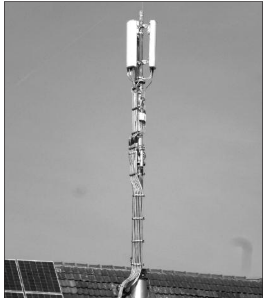
O2-Antenne auf einer Scheune, Westertor 28.
