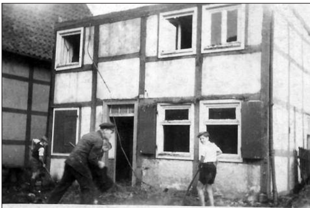
Das Haus Köneke am Alten Markt wurde am 19. September 1944 schwer zerstört.
