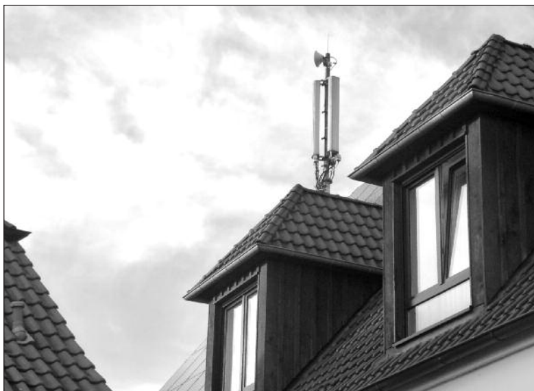
Die Vodafone-Antenne auf dem Gasthof Kemper, Aspenstraße 6.
