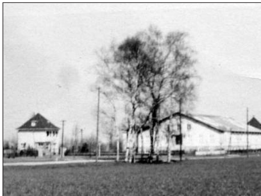
Ehemalige Salzhütte an der Reichsstraße 55, rechts im Hintergrund Hof Hötte.
