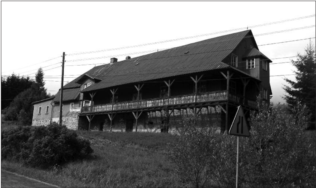
1927 errichtete der Großvater von Jürgen Ponzel einen großen Anbau, der auch für Tanzveranstaltungen genutzt wurde. Das Gebäude steht heute zum Verkauf.
