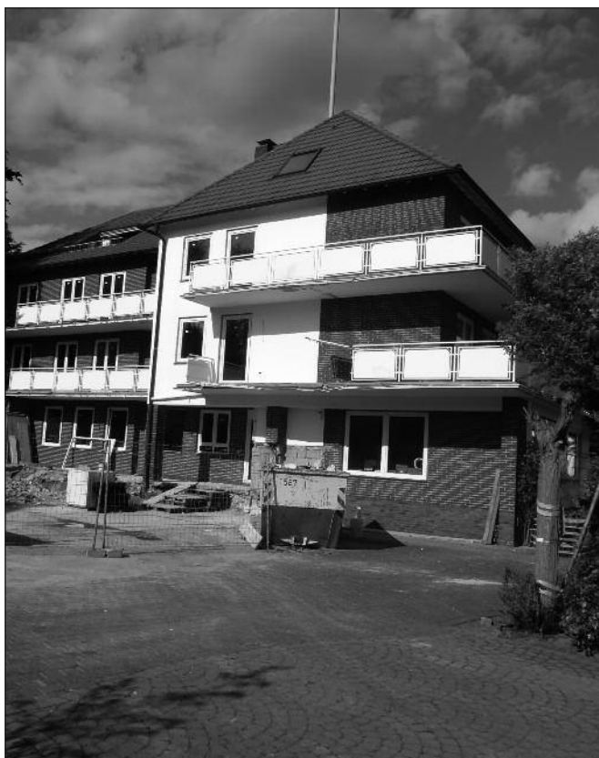
Umbau der ehemaligen Pension Haus Margareta (Aufnahme vom 17.5.2015).
