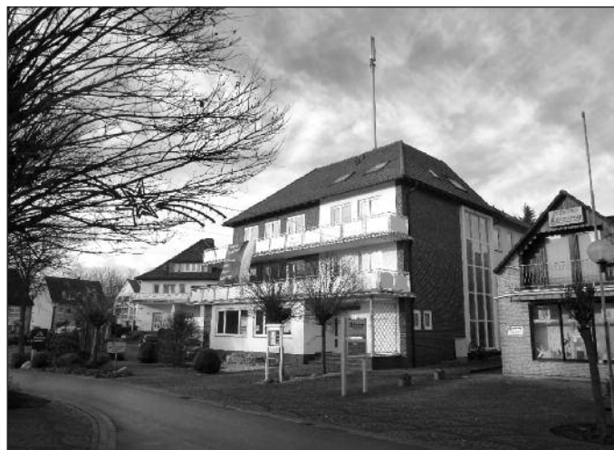
Die Telekom-Antenne auf der ehemaligen Pension Haus Margareta, Weringhauser Straße 6.
