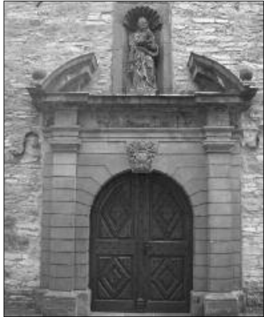
Oberhalb des Westportals des Bad Westernkötter Kirchturms weisen vier Maueranker auf das Jahr 1699 hin. Acht Jahre vorher war auch die Kapelle einem verheerenden Brand zum Opfer gefallen.
