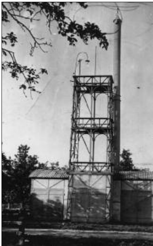
Auch ein Steigerturm war noch 1926 in Westernkotten vorhanden, hier ein Foto des ehemaligen Steigerturms in Erwitte.
