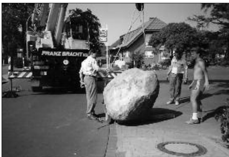
Mit einem Kran der Firma Bracht wurde der Stein Anfang der 1980er Jahre versetzt.
