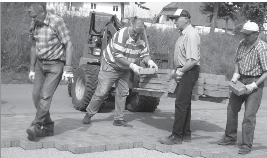
Bei Pflasterarbeiten am Holzweg im Sommer 2009.
