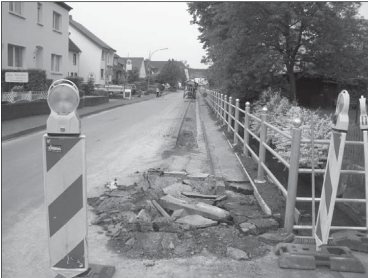
Das alte Schrammbord wird durch einen gepflasterten Fußweg ersetzt.
