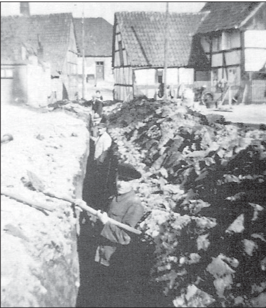
Frühjahr 1934: Die Erdarbeiten für die zu verlegende Wasserleitung auf dem Kirchplatz haben begonnen.
