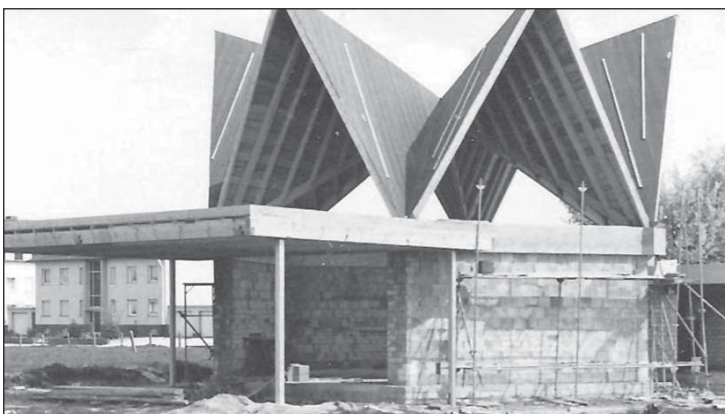
Friedhofshalle im Bau.
